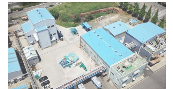
PO3G 생산설비 건설 중
